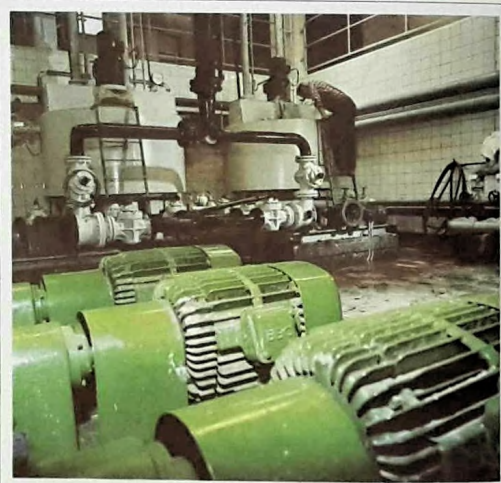
(٨) - يحول المحرك الكهربائي الطاقة الكهربائية الى طاقة ميكانيكية او حركية . النوع الدوراني منها هو الاكثر شيوعا . وفيه يدور دوار ( روتور ) داخل ساكن ثابت ( ستاتور ) .
